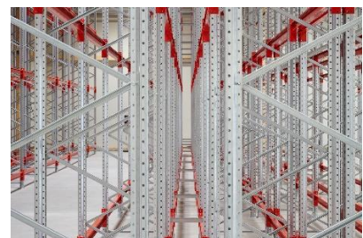
vue intérieure des alvéoles de l'entrepôt
