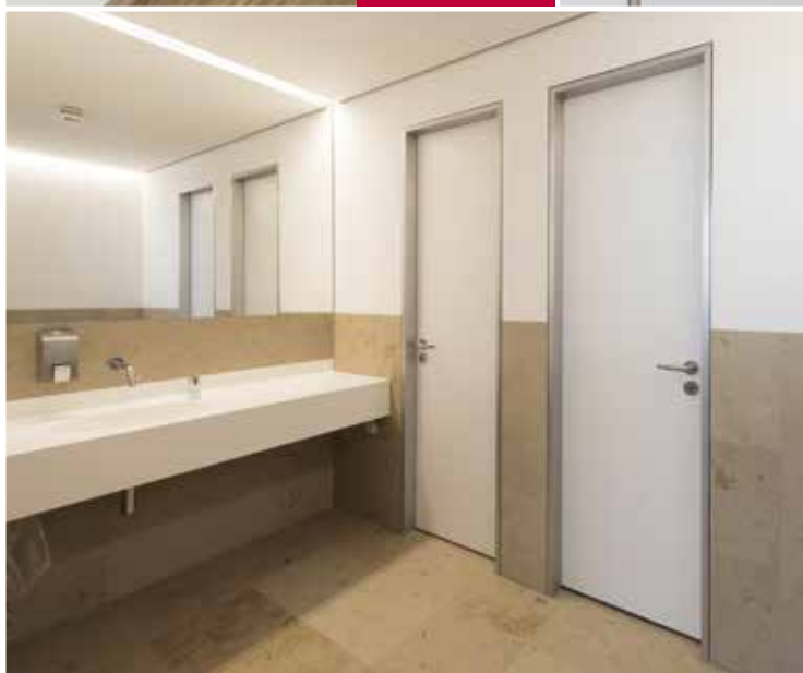
Stipite in alluminio LZS ed LZBS con la stessa larghezza dello specchio a vista
